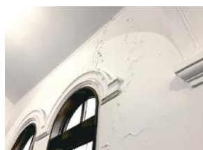
塗装が硬化してひび割れや剥がれなど 深刻な劣化が随所に見られる
