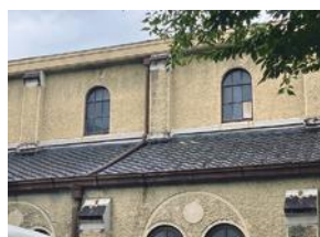
瓦のずれや雨樋の詰まりにより 雨漏りが起きている
