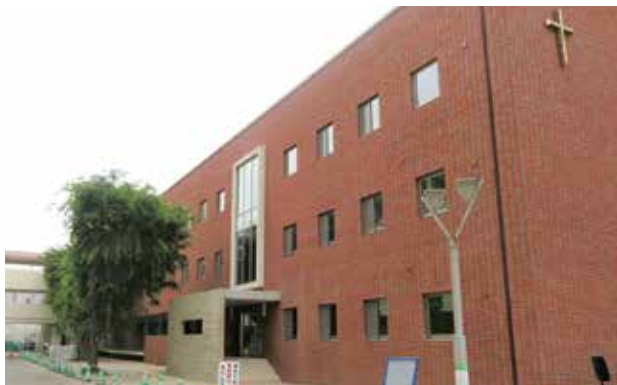
2号館外観〔西方から撮影〕 (赤煉瓦タイル外壁と十字架)
