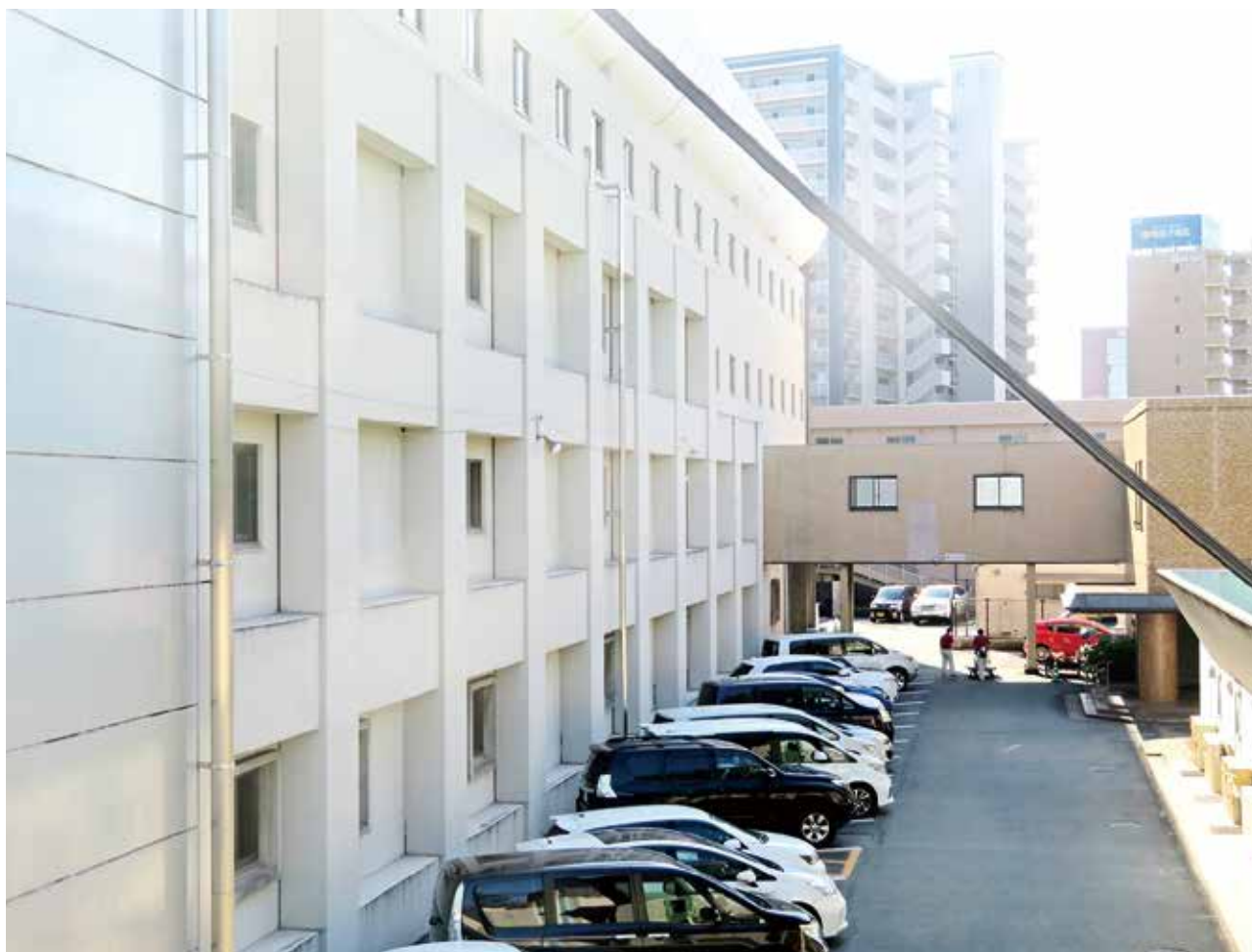
1号館北側外壁（柱と外壁アウトフレームを補強した）
