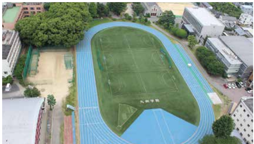
グラウンド改修工事竣工(人工芝導入、トラックは青色に)
