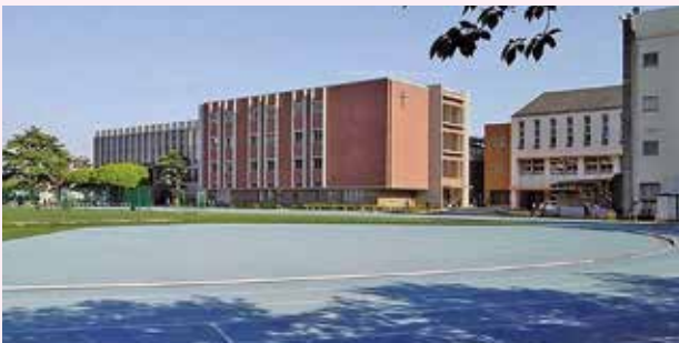
3月に竣工した中学校校舎(4号館)を総合体育館から望む
